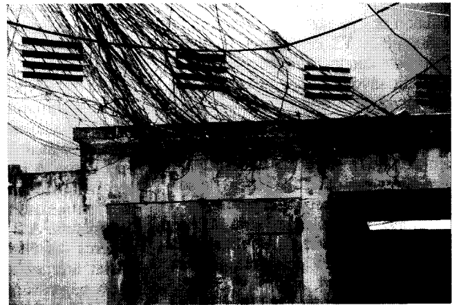
„Csináld magad” alapon a villamoshálózat (220 V!) bekötése a körzeti trafóházba
